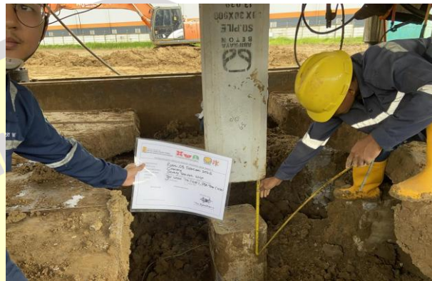
Gambar 59 PDA Test pada tiang pancang
