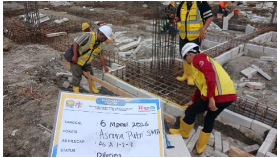
Gambar 46 Checklist pembesian pile cap
