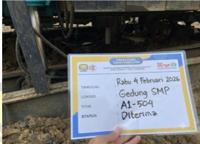
Gambar 13 Dokumentasi pekerjaan tiang pancang
