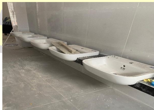
Gambar 45 Monitoring pemasangan wastafel
