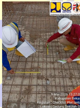
Gambar 56 Checklist pembesian pelat lantai
