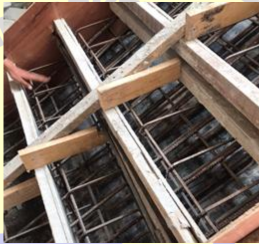
Gambar 30 Monitoring fabrikasi tulangan
