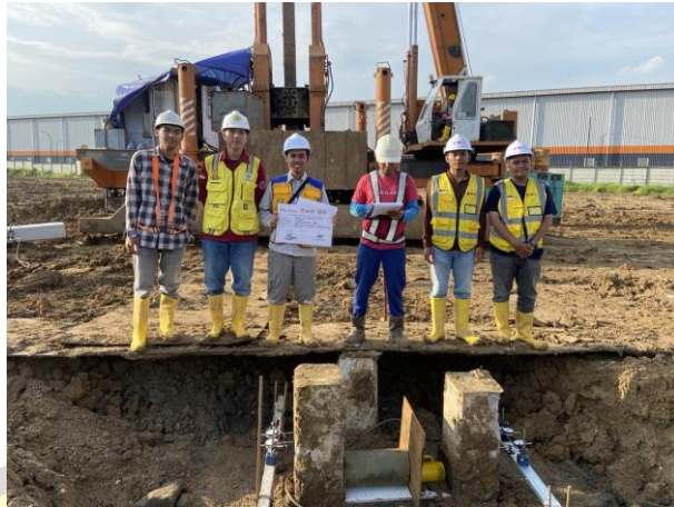
Gambar 60 Pengujian lateral untuk tiang pancang
