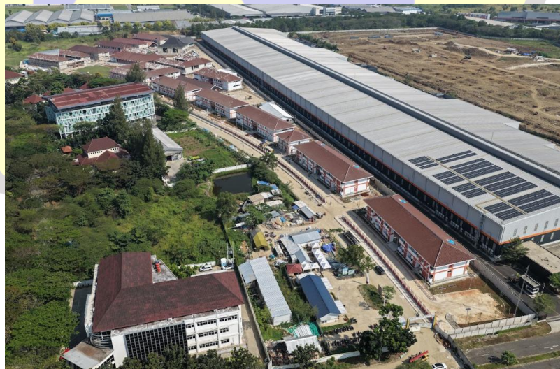
Gambar 12 Progres Proyek 75% Sumber : Dokumen Proyek, 2026
