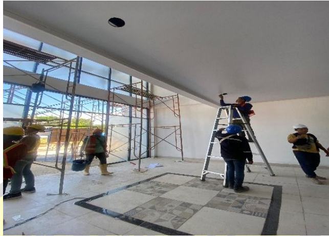
Gambar 44 Monitoring pemasanganudukan lampu
