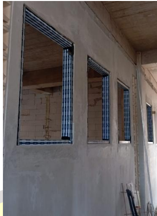
Gambar 66 Dokumentasi pemasangan kusen pada Gedung Sekolah SMP
