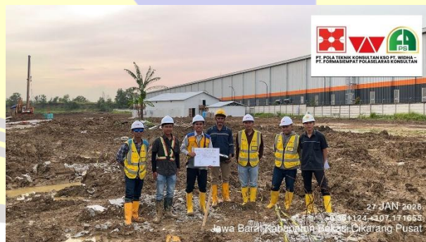
Gambar 58 Pengujian PIT pada tiang pancang
