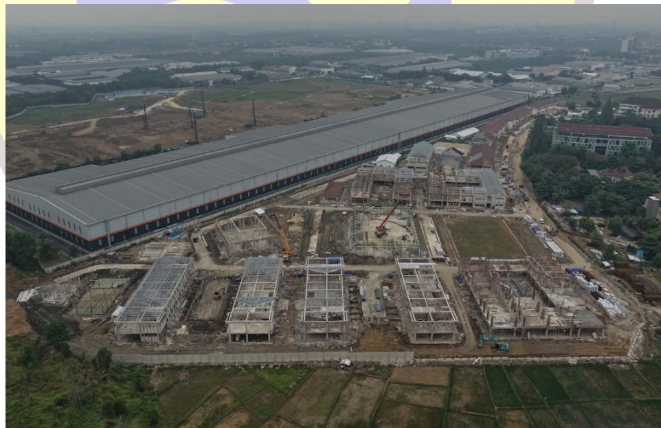
Gambar 10 Progres Proyek 50% Sumber : Dokumen Proyek, 2026
