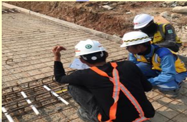
Gambar 33 Pengecekan tulangan rigid
