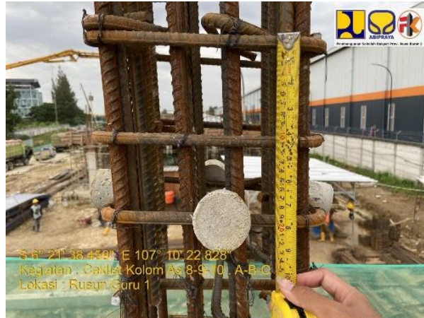
Gambar 51 Checklist pembesian kolom
