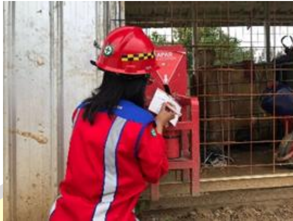
Gambar 25 Pengecekan kondisi APAR
