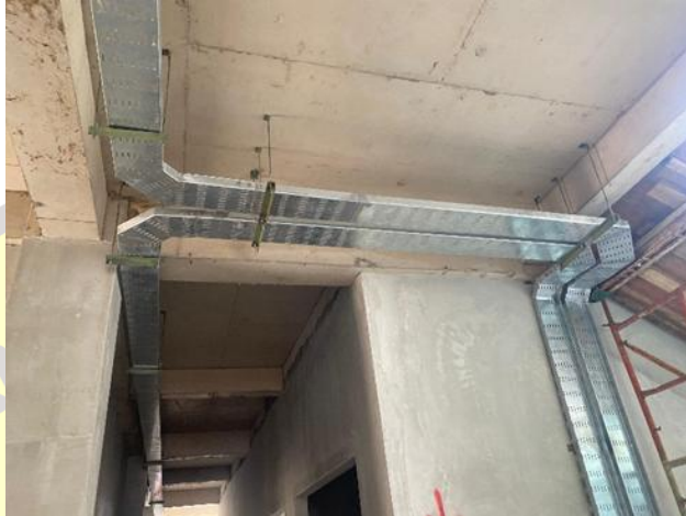
Gambar 43 Monitoring pemasangan pelindung kabel
