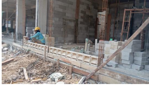
Gambar 62 Melakukan pengawasan pekerjaan pemasangan roster beton
