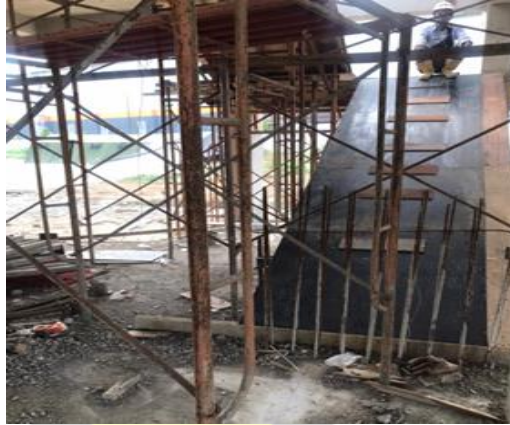
Gambar 29 Mengikuti pekerjaan marking tangga
