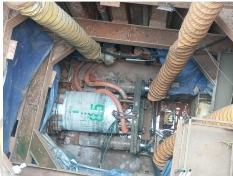
Gambar 3. 10 Pekerjaan Pipe Jacking Sumber: Penulis (2026)
