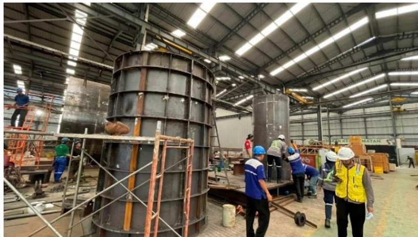
Gambar 3. 8 Inspeksi Fabrikasi Bekisting Manhole Sumber: Penulis (2026)
