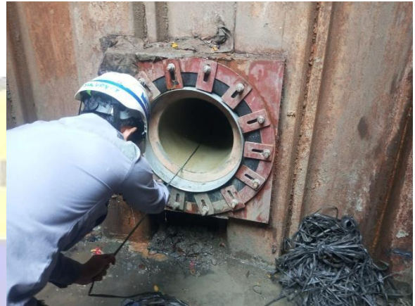
Dokumentasi Pemeriksaan Visual Pipa dengan GoPro
