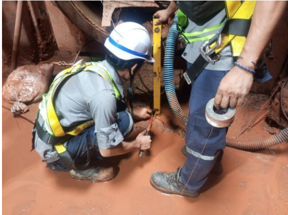
Dokumentasi Marking Manhole
