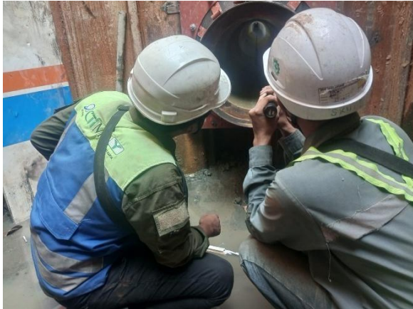
Dokumentasi Pemeriksaan Visual Pipa
