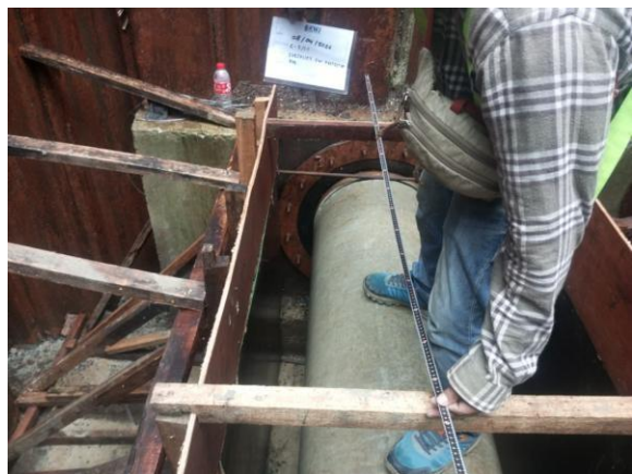
Dokumentasi Checklist Protection Pipe
