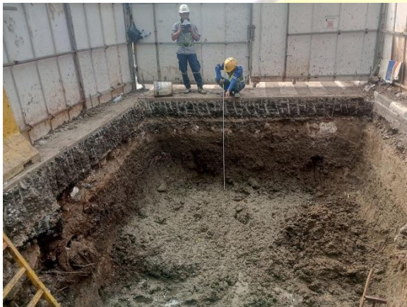
Dokumentasi Pengukuran Galian Diversion Chamber
