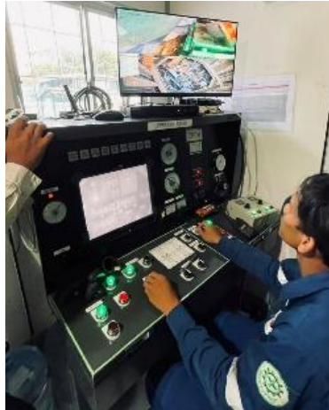
Gambar 2. 20 Pengoperasian Mesin Jacking Sumber: KWJJV (2024)
