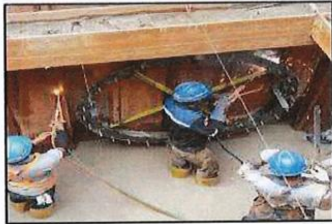
Gambar 2. 38 Pemasangan Exit Ring
