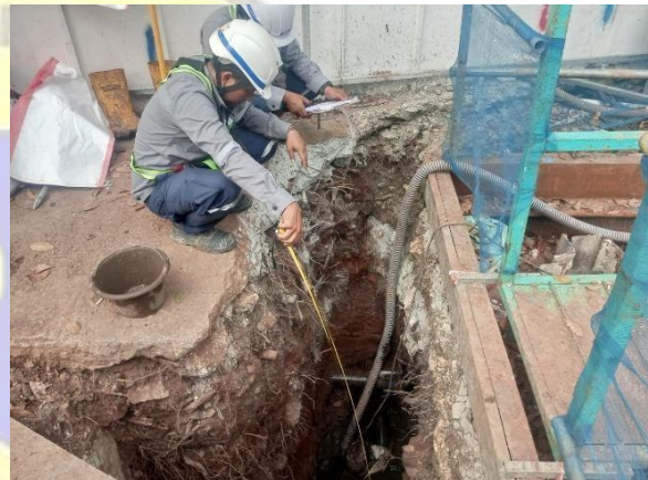
Dokumentasi Pengukuran Aktual Pipa
