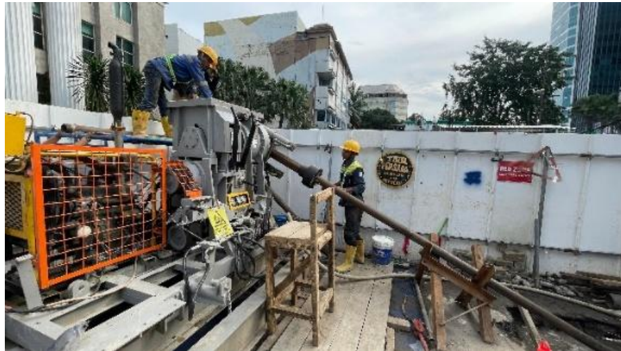
Gambar 3. 11 Pekerjaan Persil Pipe Sumber: Penulis (2026)
