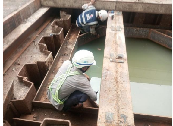
Dokumentasi Pembuatan Titik Shaft
