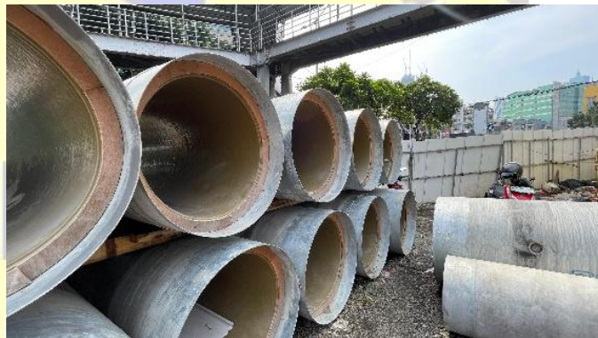
Gambar 2. 21 Pipa Reinforced Concrete Pipe (RCP) Sumber: Dokumentasi Penulis (2026)
