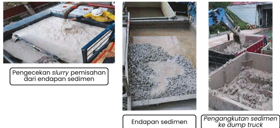
Gambar 2. 18 Proses Pembuangan Slurry ( Discharge ) Sumber: KWJJV (2024)
