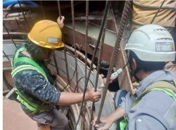
Dokumentasi Checklist Rebar Manhole
