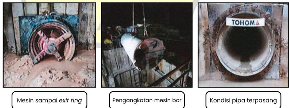
Gambar 2. 40 Pengangkatan Mesin Bor Sumber: KWJJV (2024)
