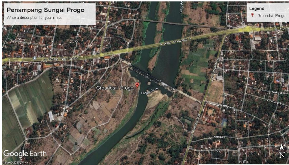
Gambar 1.2 Penampang Sungai Progo sebelum pembangunan Groundsill Srandakan Sumber: Google Earth , 2025
