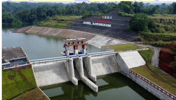
Gambar 1. 1 Bendungan Kuwil Kawangkoan
