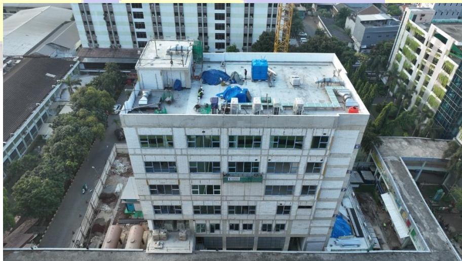
Gambar 2. 2 Bangunan Gedung Powerhouse RSJPD Harapan Kita (Sumber : dokumentasi peneliti)
