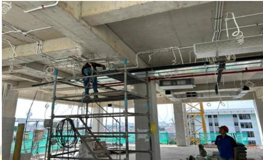
Gambar 2. 5 Pekerjaan MEP Gedung Powehouse RSJPD Harapan Kita (Sumber : dokumentasi peneliti)
