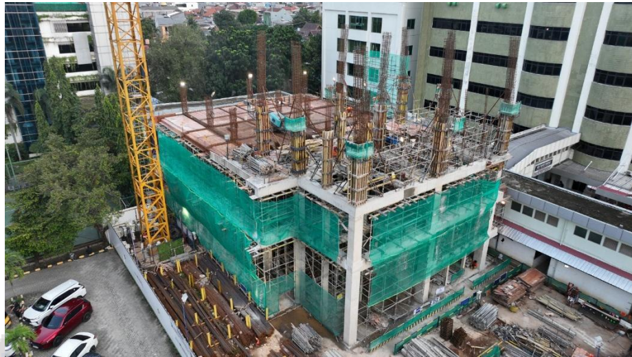
Gambar 2. 3 Pekerjaan Struktur Gedung Powerhouse RSJPD Harapan Kita (Sumber : dokumentasi peneliti)
