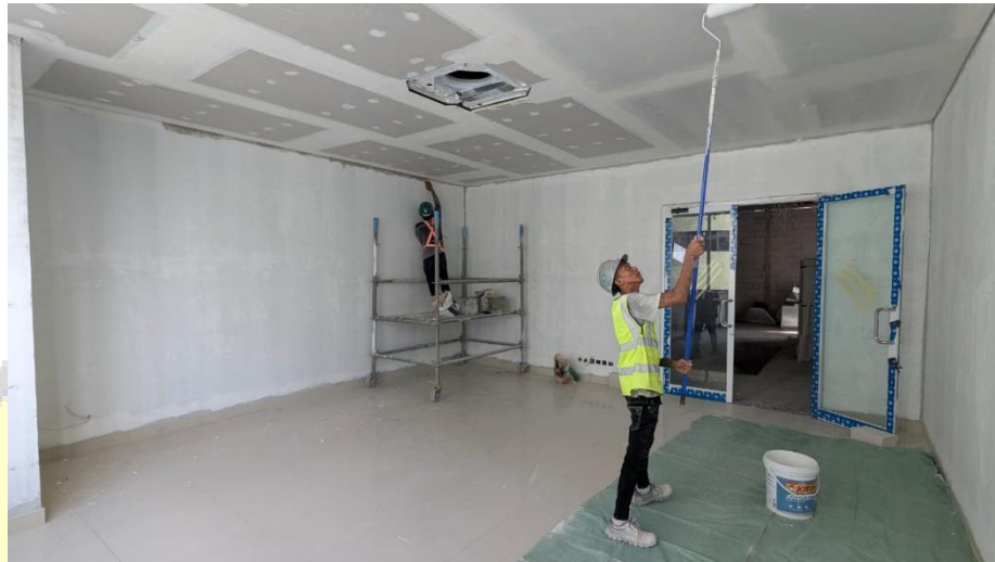
Gambar 2. 4 Pekerjaan Arsitektur Gedung Powehouse RSJPD Harapan Kita (Sumber : dokumentasi peneliti)
