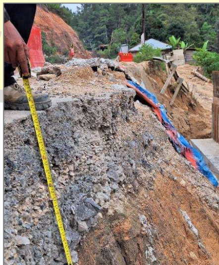
Gambar 3. 156 Pengukuran Tebal Perkerasan Sumber: Dokumentasi Penulis, 2026
