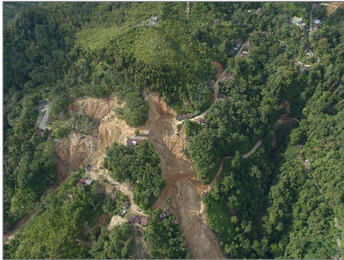
Gambar 3. 153 Dokumentasi Longsor Sumber: Dokumentasi Penulis, 2026
