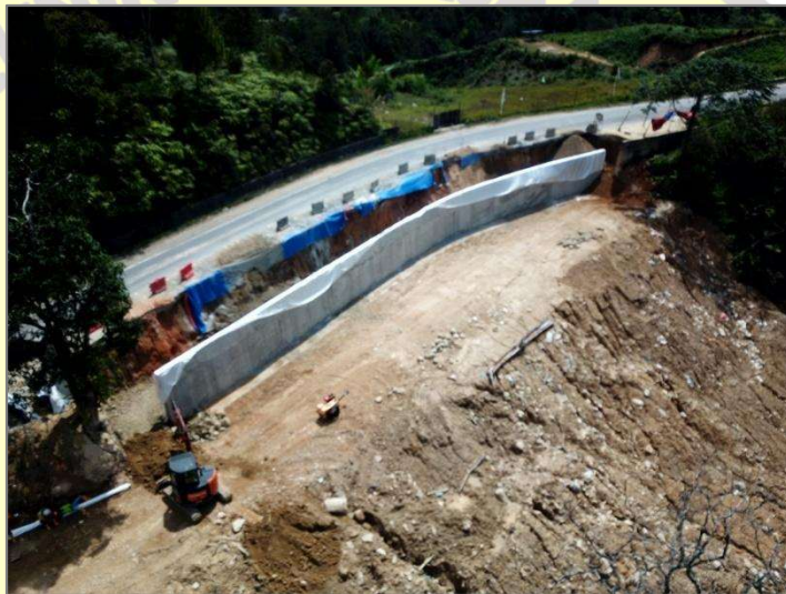
Gambar 3. 154 Dokumentasi Progres Pekerjaan DPT Sumber: Dokumentasi Penulis, 2026
