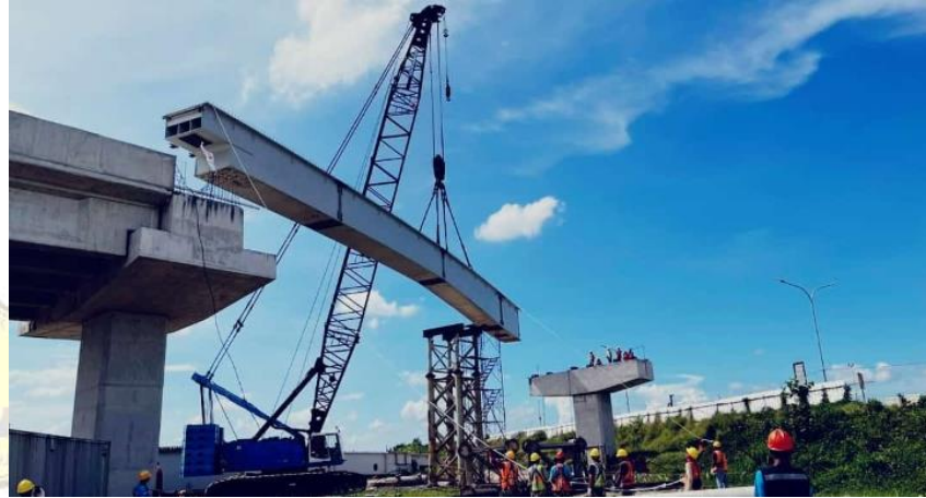
Gambar 1. 2 Erection SBG
