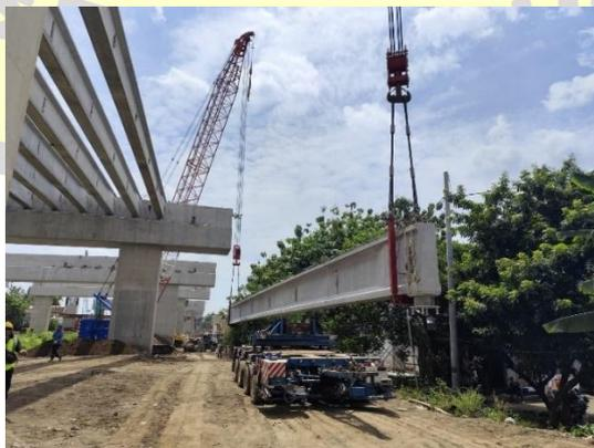
Gambar 1. 1 *Erection PCI Girder dengan Crawler crane*
