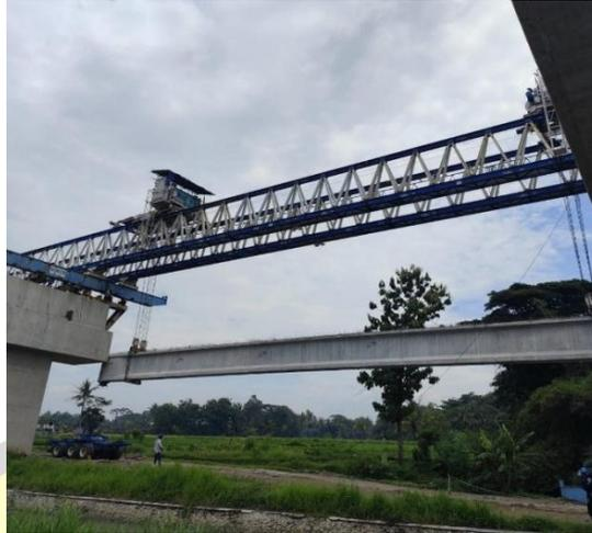
Gambar 1. 2 *Erection PCI Girder dengan Launcher*
