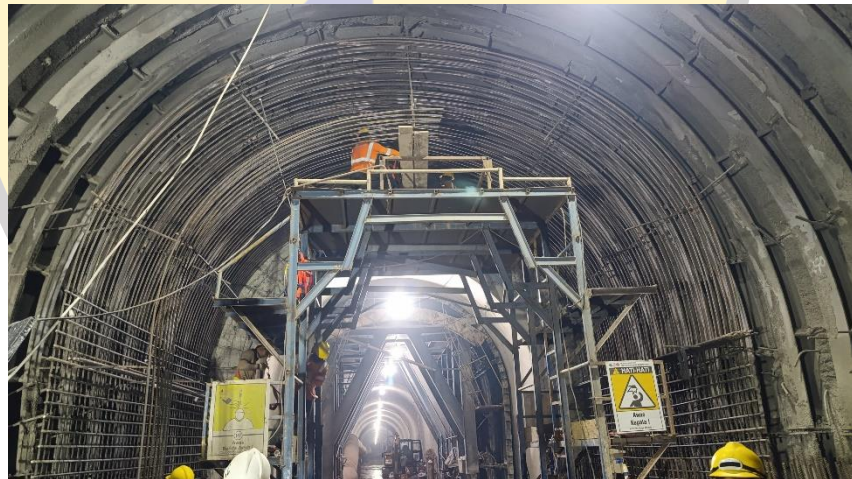
Gambar 4. 44 Pekerjaan Pembesian Dinding Crown (Sumber : Dokumentasi Pribadi, 2025)
