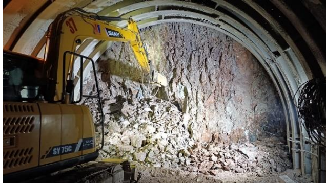
Gambar 4. 35 Pekerjaan Galian Upper (Sumber : Dokumentasi Pribadi, 2025)
