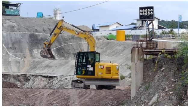
Gambar 4. 2 Mini Excavator CAT 307 (Sumber : Dokumentasi Pribadi, 2025)
