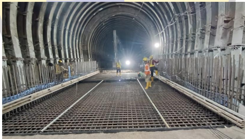
Gambar 4. 28 Bekisting (Sumber : Dokumentasi Pribadi, 2025)
