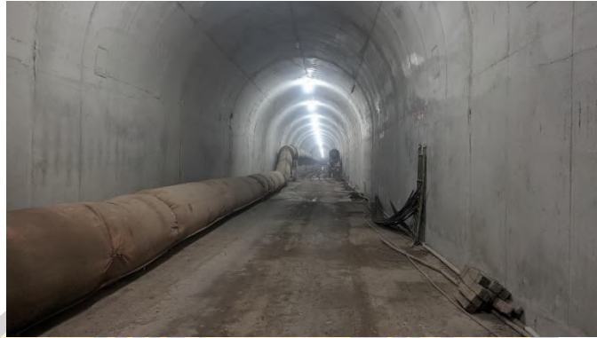
Gambar 4. 19 Beton Lining Terowongan Pengelak (Sumber : Dokumentasi Pribadi, 2025)
