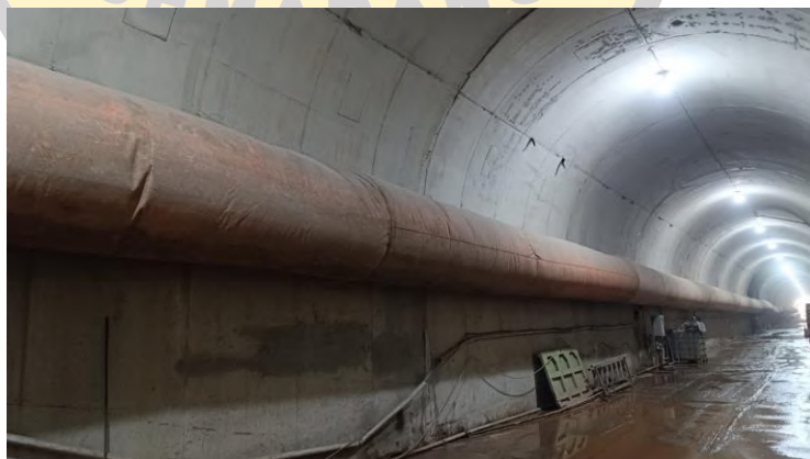
Gambar 4. 61 Duckting (Sumber : Dokumentasi Pribadi, 2025)
