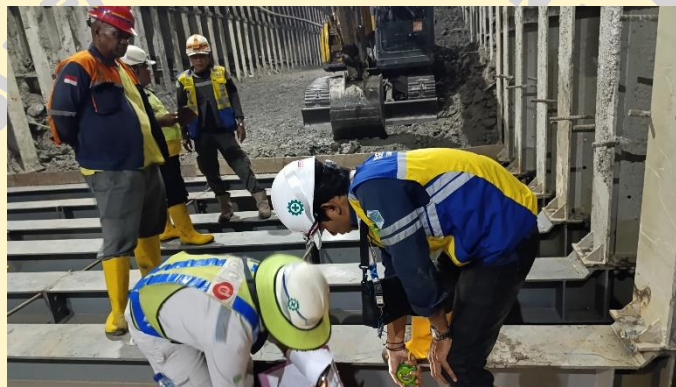
Gambar 4. 73 Joint Inspection Pemasangan Invert (Sumber : Dokumentasi Pribadi, 2025)
