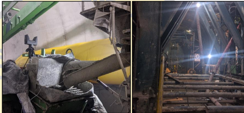
Gambar 4. 48 Proses Pengecoran Lining Dinding Crown (Sumber : Dokumentasi Pribadi, 2025)
