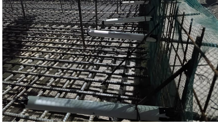
Gambar 4. 27 Dowel Bar (Sumber : Dokumentasi Pribadi, 2025)
