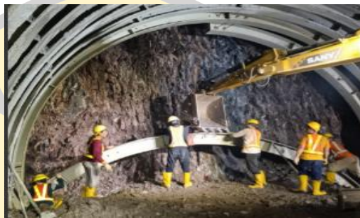
Gambar 4. 36 Pekerjaan Pemasangan Steel Rib Upper/Crown (Sumber : Dokumentasi Pribadi, 2025)
