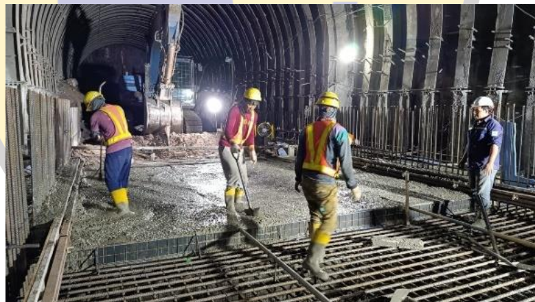
Gambar 4. 43 Pekerjaan Pengecoran Slab (Sumber : Dokumentasi Pribadi, 2025)
