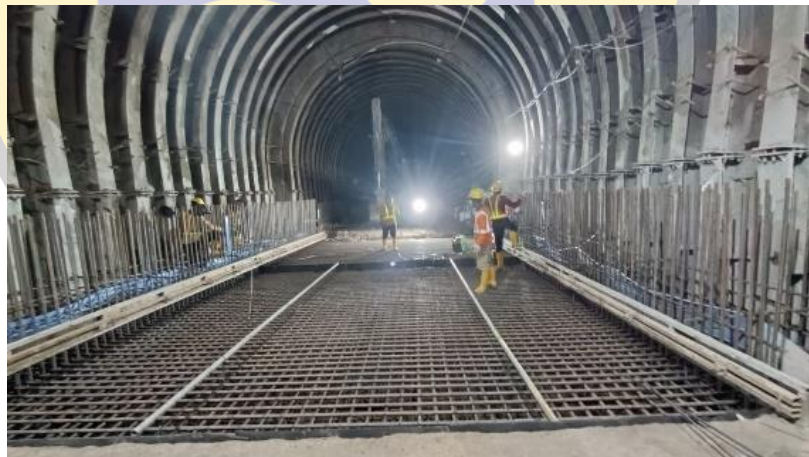
Gambar 4. 42 Pekerjaan Pemasangan Bekisting Slab (Sumber : Dokumentasi Pribadi, 2025)
