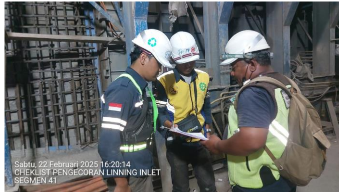
Gambar 4. 72 Joint Inspection Pengecoran Lining (Sumber : Dokumentasi Pribadi, 2025)
