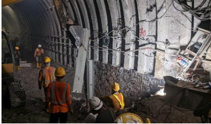
Gambar 4. 37 Pekerjaan Pemasangan Steel Rib Lower (Sumber : Dokumentasi Pribadi, 2025)
