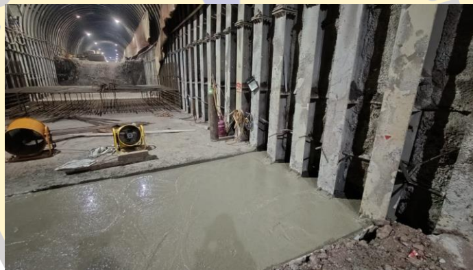
Gambar 4. 20 Beton Pengisi Celah Invert (Sumber : Dokumentasi Pribadi, 2025)
