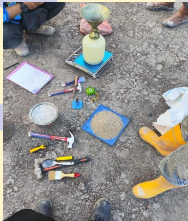
Gambar 4. 52 Pengujian Sandconne (Sumber : Dokumentasi Pribadi, 2025)
