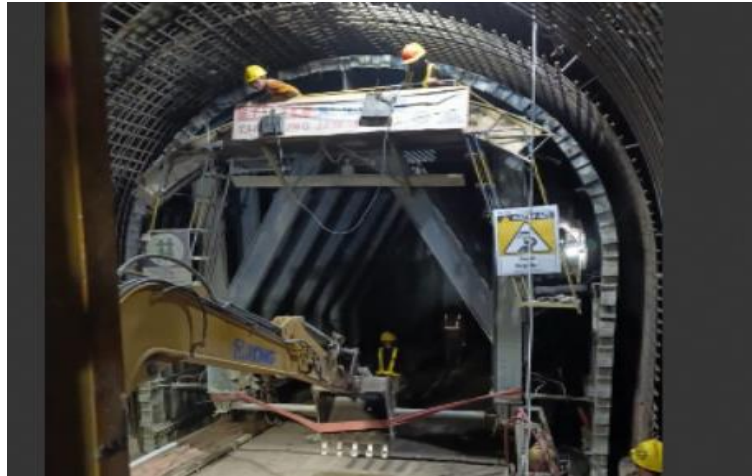
Gambar 4. 46 Mobilisasi Sliding Form (Sumber : Dokumentasi Pribadi, 2025)
