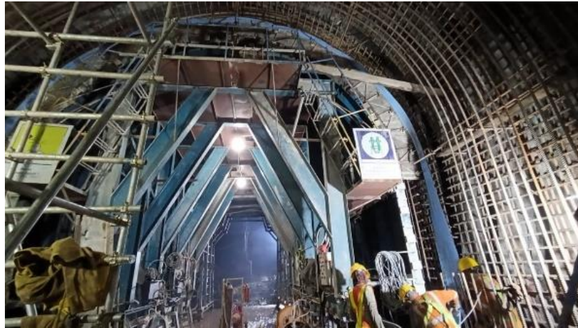
Gambar 4. 45 Pemasangan Waterstop (Sumber : Dokumentasi Pribadi, 2025)
