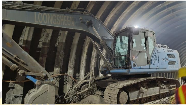
Gambar 4. 4 Excavator LX210-9B (Sumber : Dokumentasi Pribadi, 2025)
