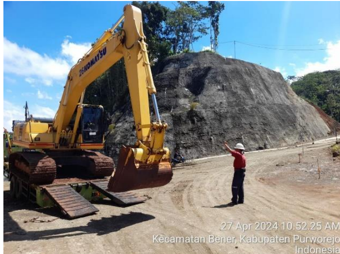
Gambar 3. 9 Excavator Bucket pada pekerjaan galian dan tanah
