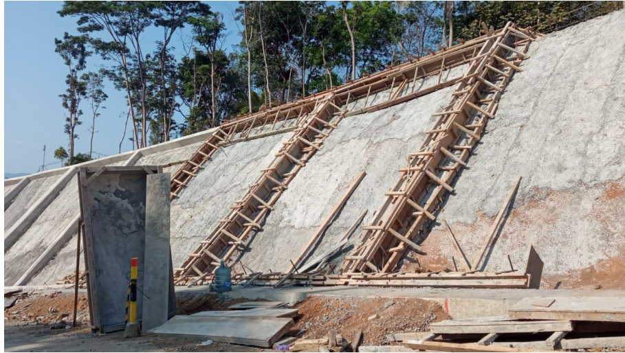
Gambar 3. 26 Bekisting pekerjaan DPT
