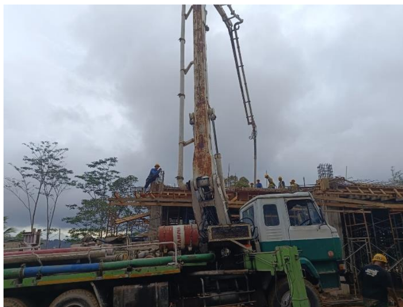
Gambar 3. 17 Concrete pump kapasitas. 8 m 3
