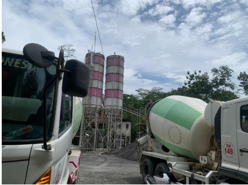
Gambar 3. 20 Batching plant kapasitas. 60 m 3 /jam
