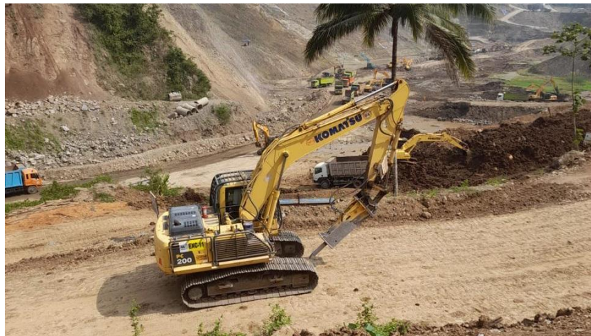
Gambar 3. 5Alat Berat Breaker di area Proyek
