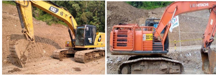
Gambar 3. 4 Alat Berat Excavator di area proyek
