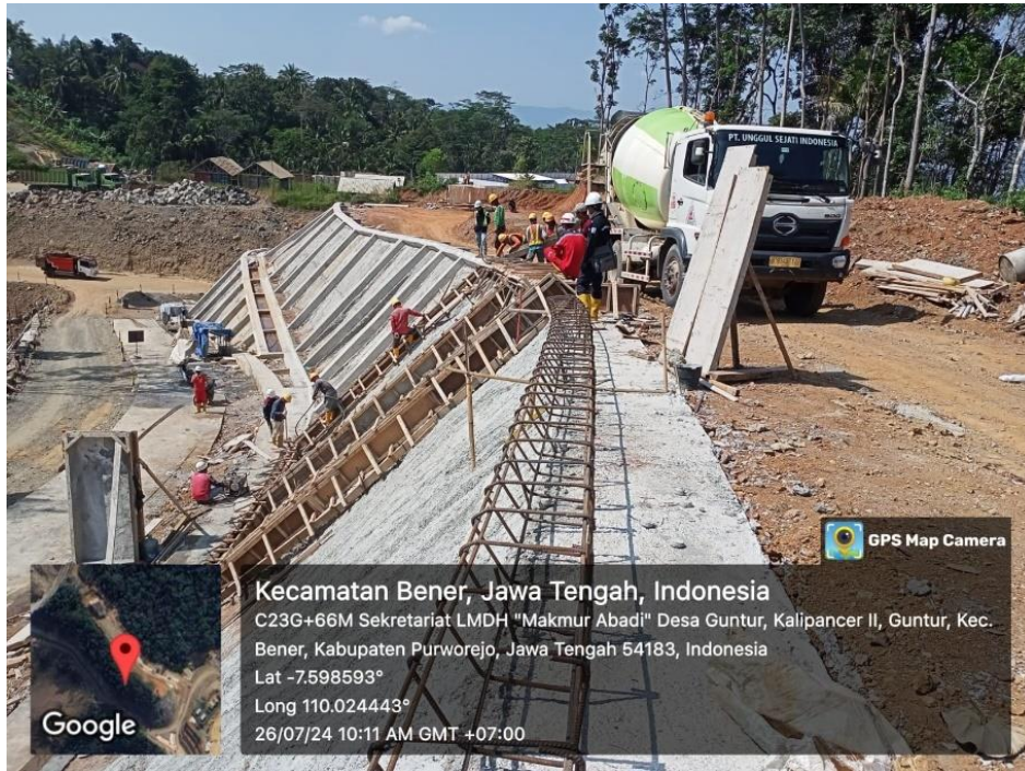
Gambar 3. 28 Pekerjaan Beton K-225
