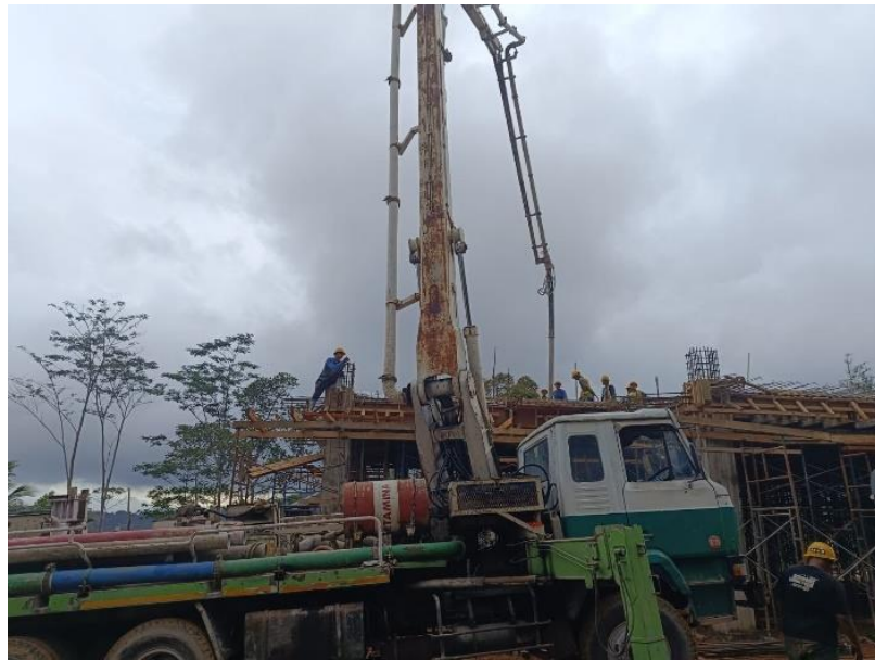
Gambar 3. 14 Concrete pump yang digunakan pada saat pekerjaan diproyek
