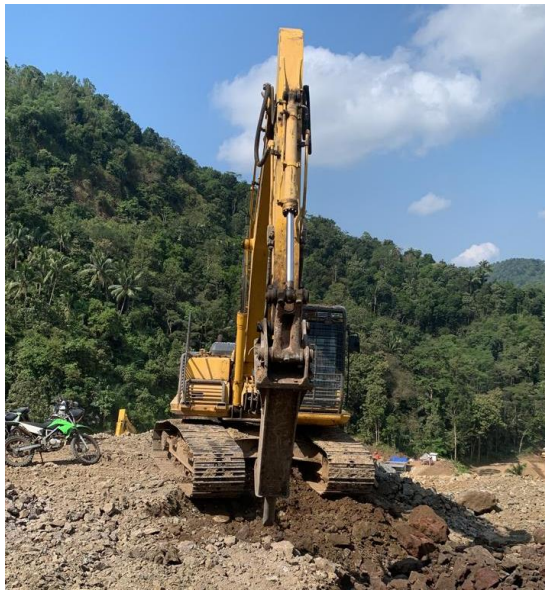
Gambar 3. 10 Excavator Breaker pada pekerjaan galian
