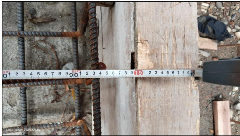
Gambar 4.5 Dokumentasi Checklist Pengecoran dan Pembesian Atap Gedung Battery Sumber : Dokumentasi Pribadi, 2024
