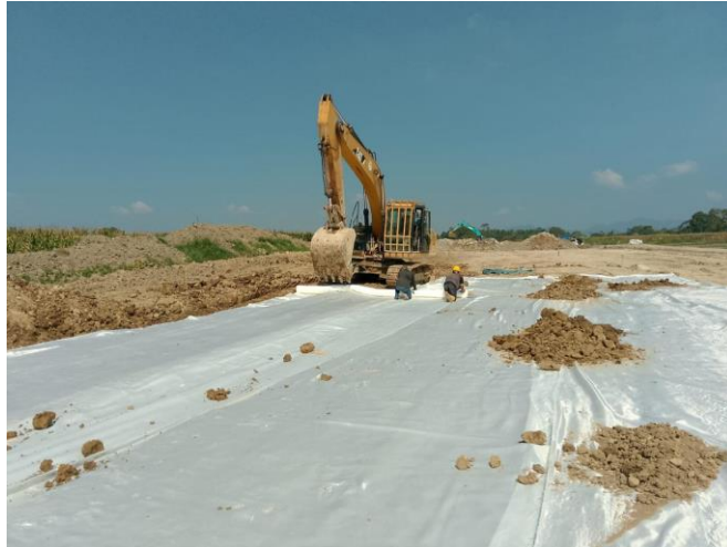
Gambar 1. 1 Penggunaan Geotextile di Lokasi Proyek Akses Interchange Raya
