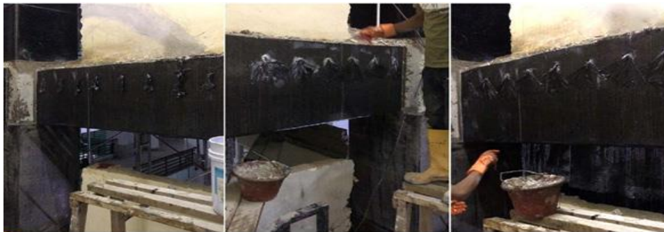
Gambar 33 Pemasangan CFRP pada Bidang Balok Struktur
