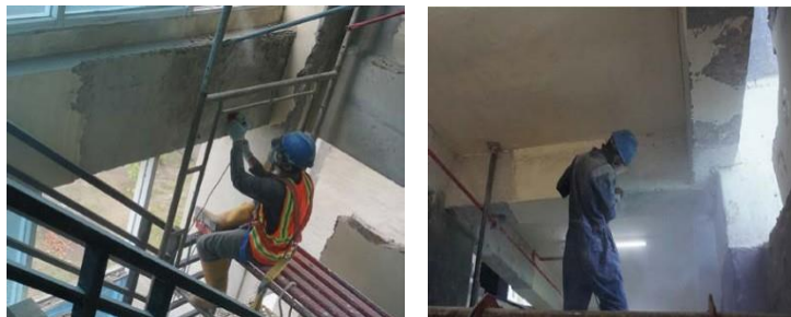
Gambar 24 Grinding Permukaan Balok dan Kolom
