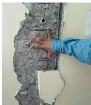
Gambar 9 Pengamatan di Lapangan terhadap pembesian kolom struktur
