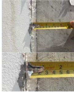
Gambar 5 Pengamatan dan Pengukuran Celah Dilatasi
