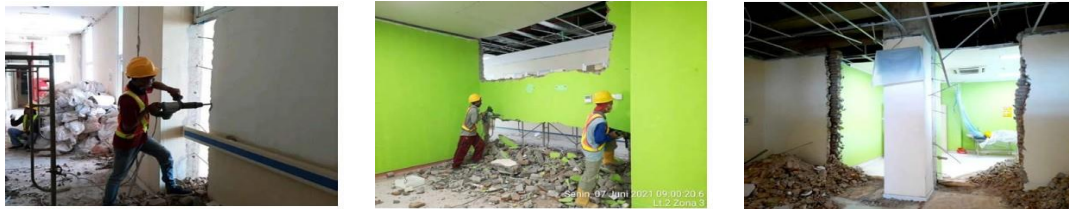
Gambar 11 Pembongkaran Dinding Eksisting pada Area Dilatasi
