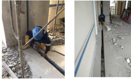
Gambar 21 Pembobokan Plat Lantai pada Area Dilatasi
