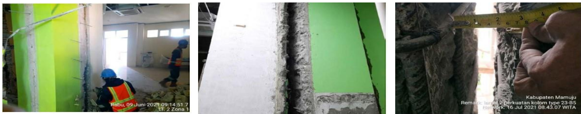
Gambar 14 Pembobokan Kolom Struktur pada Area Dilatasi
