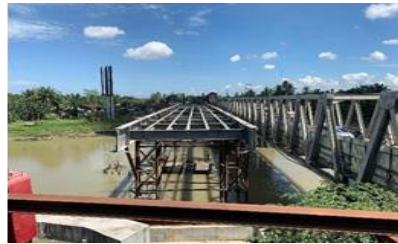
Gambar 2 Kondisi Eksisting Sistem Lantai Sei Wampu
