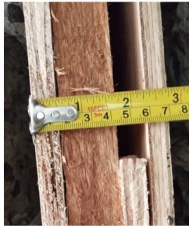
Gambar 17 Pengukuran Tebal Bekisting 70 mm agar Sesuai dengan Celah Dilatasi yang Diinginkan
