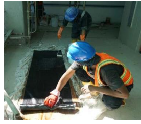
Gambar 28 Persiapan Lembar CFRP dengan Memberikan Lem Perekat Epoxy
