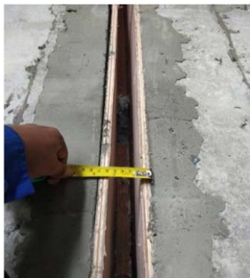
Gambar 19 Pengukuran Kembali Lebar Celah Dilatasi Setelah Pengecoran
