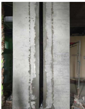
Gambar 20 Pasca Pengecoran Beton Grouting pada Kolom yang Sudah Dibobok
