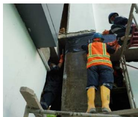
Gambar 29 Pemberian Lem Epoxy pada Bidang Kolom untuk Pemasangan CFRP
