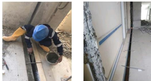
Gambar 22 Perapian pada bidang Plat Lantai yang sudah dibobok
