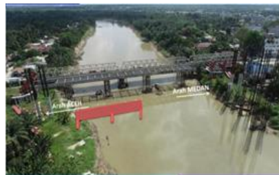
Gambar 11 Metode Backstay and Mobile Crane 150 ton pada Bailey 2 x 30 m
