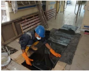
Gambar 28 Persiapan Lembar CFRP dengan Memberikan Lem Perekat Epoxy
