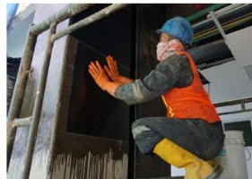
Gambar 30 Pemasangan CFRP pada Kolom
