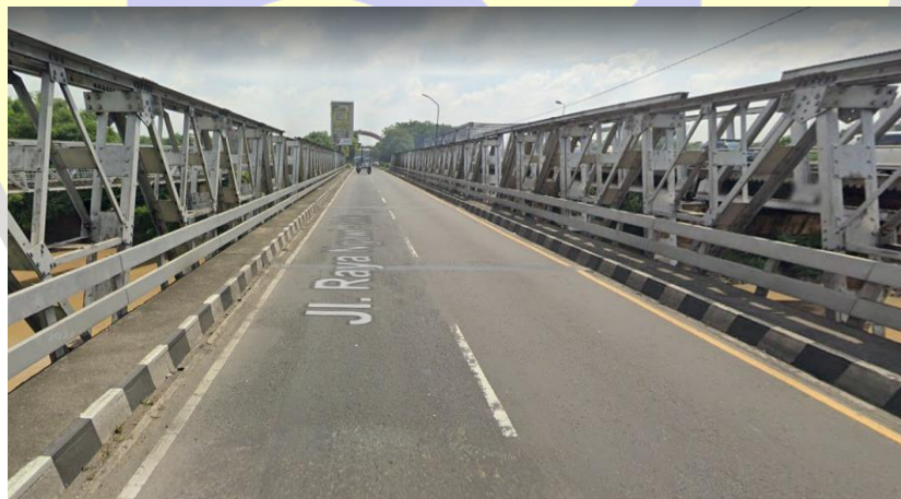
Gambar 1. 1 Jembatan CH Jurug B sebelum dibongkar (Sumber : Google Maps)
