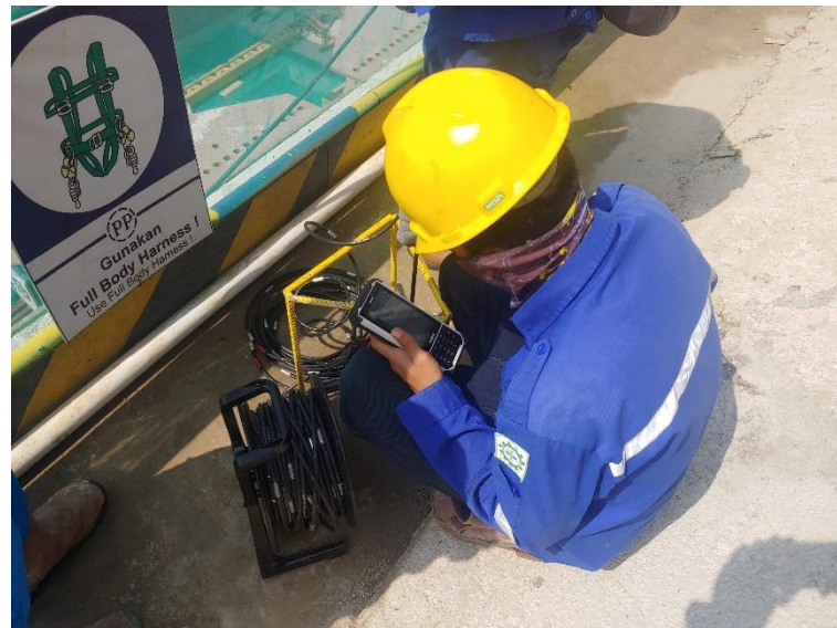
Gambar 43 Proses uji Inclinometer . Sumber : Dokumentasi Lapangan
