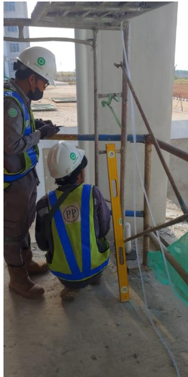
Gambar 147 Proses mematok elevasi lantai balkon. Sumber : Dokumentasi lapangan
