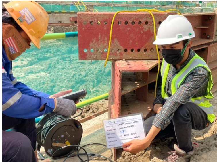
Gambar 33 Checklist pengujian Inclinometer . Sumber : Dokumentasi lapangan
