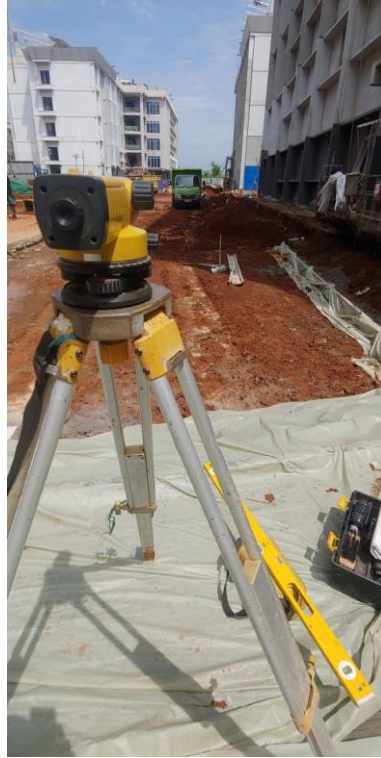
Gambar 146 Proses mematok elevasi jalan. Sumber : Dokumentasi lapangan
