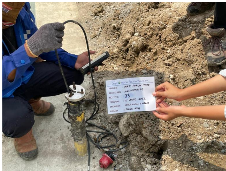
Gambar 34 Proses pengujian Inclinometer . Sumber : Dokumentasi lapangan
