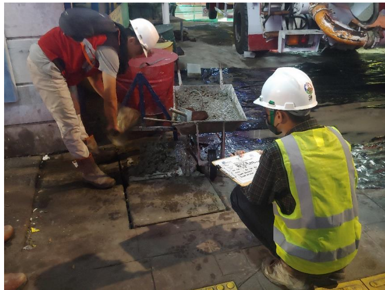
Gambar 35 Proses pengambilan sampel slump test . Sumber : Dokumentasi lapangan
