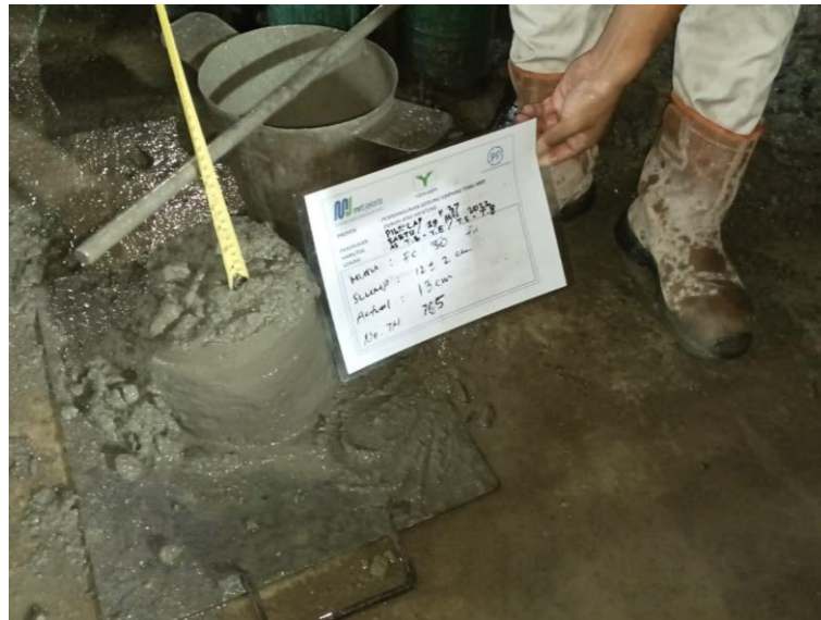
Gambar 36 Proses pengujian slump test .
